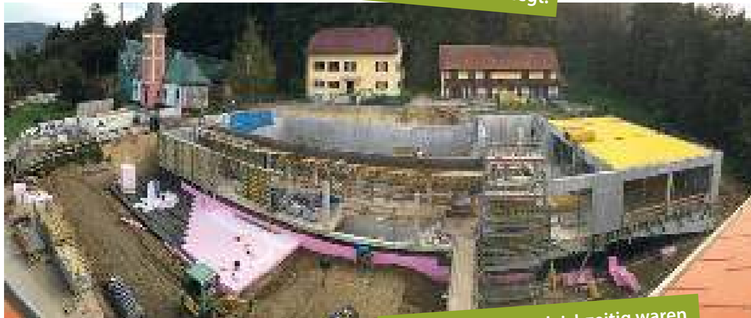
Etwa 60.000 m Kabel wurden verlegt.
